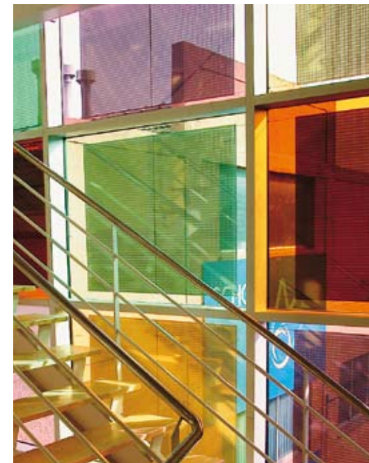
Schott office building Sant Adrià de Besòs (ES): thin-film modules, back side with colored glass Schott Verwaltung, Sant Adrià de Besòs (E): Dünnschichtmodule, rückseitig mit farbigen Gläsern
