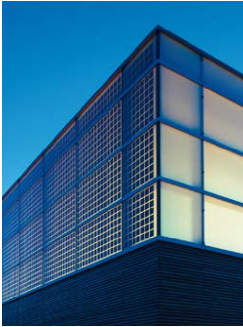
Sports Hall, Burgtweining (D), Regensburg Building Department, T. Ruf 2004 Sporthalle, Burgtweining (D), Hochbauamt Regensburg, T. Ruf 2004
